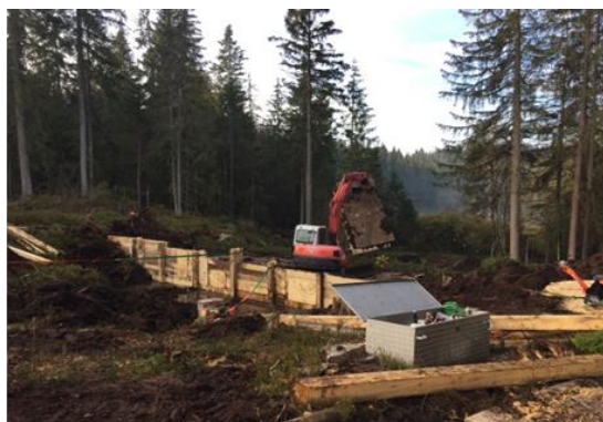
Opere di risanamento (ottobre 2018)
