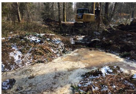
Esecuzione delle misure di valorizzazione
