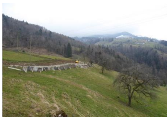
Durante il ripristino
